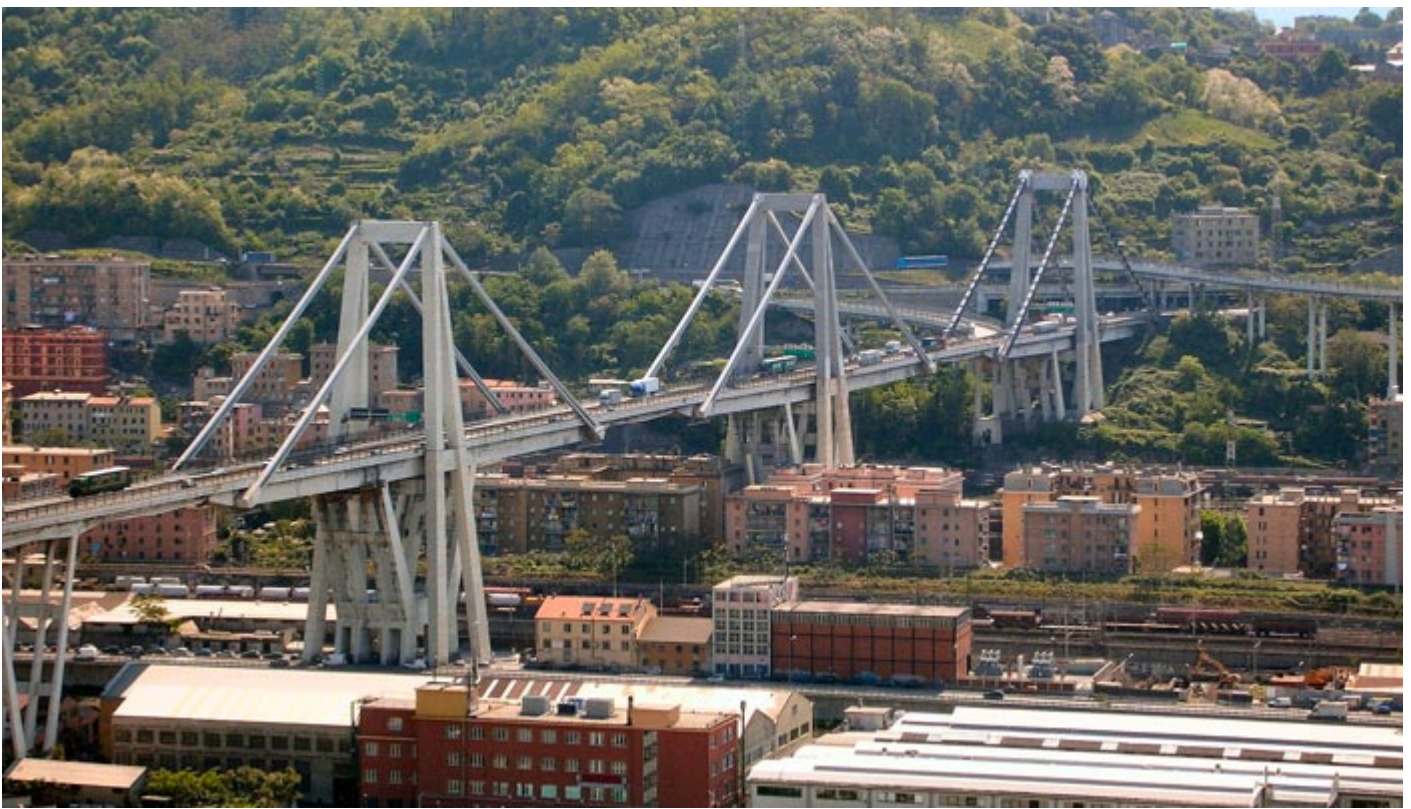
Il ponte Morandi sul Polcevera (com'era)
