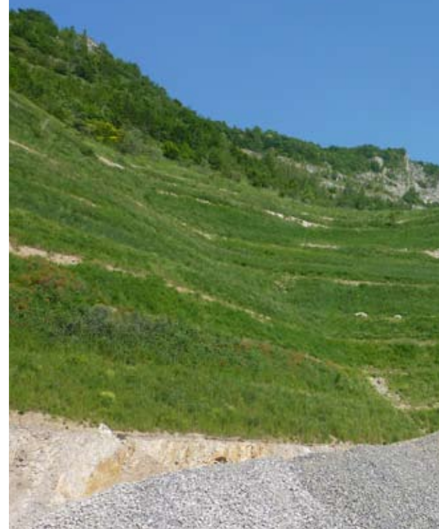
Esempi di metodo di coltivazione dall'alto verso il basso con fronti di altezza contenuta (4-5 metri) per consentire l'adeguato rimodellamento morfologico dove è stato minimizzato l'impatto visivo.
